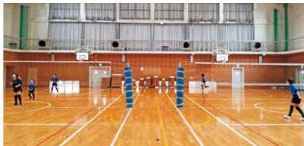
五荘小学校に設置された空調設備
