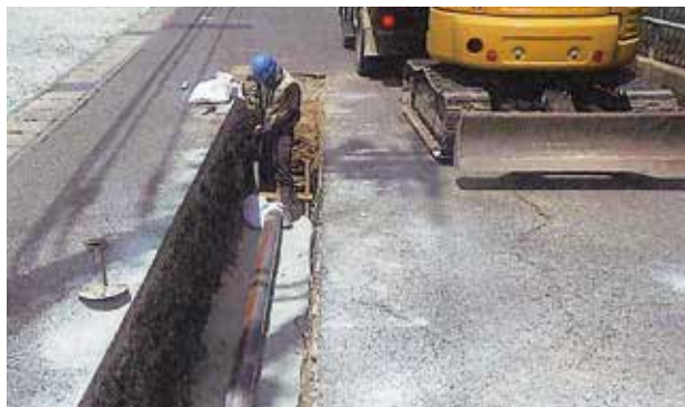
生活に必要な下水道管布設工事
