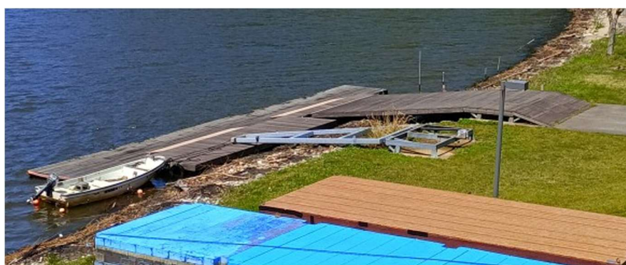
城崎ボートセンター常設栈橋全景
