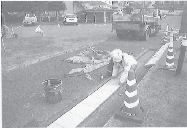
点字ブロック設置工事
