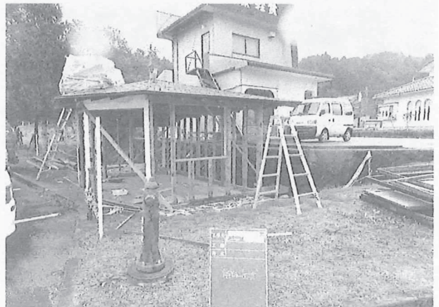
販売所の解体作業
