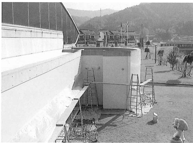
A棟西側外壁塗装工事
