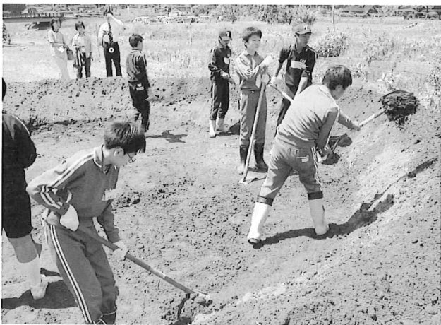
（竪穴式住居敷地造成）
