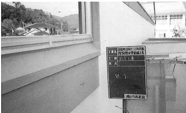
(漏水防止工事)
