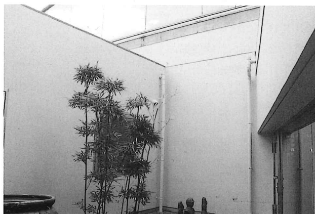
（中庭外壁補修・塗装）
