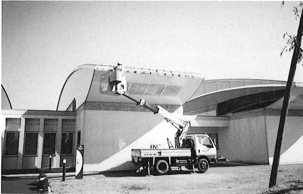
(雨漏りの修理)
