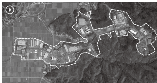
産業用地の候補地となる適地を選定します。写真は、既に完売している豊岡中核工業団地(豊岡市神美台)
