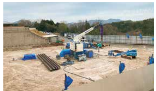
建築に着手した救命救急センター東新棟
