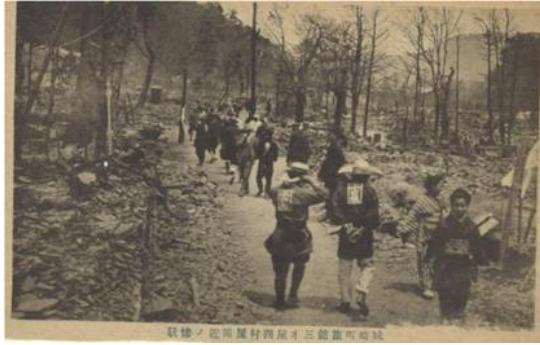
旅館三木屋西村屋付近の惨状
