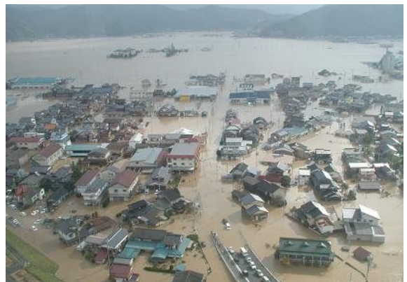
平成16年(2004)台風23号による洪水 (江本付近)
