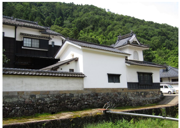
修復された経王寺鐘楼
