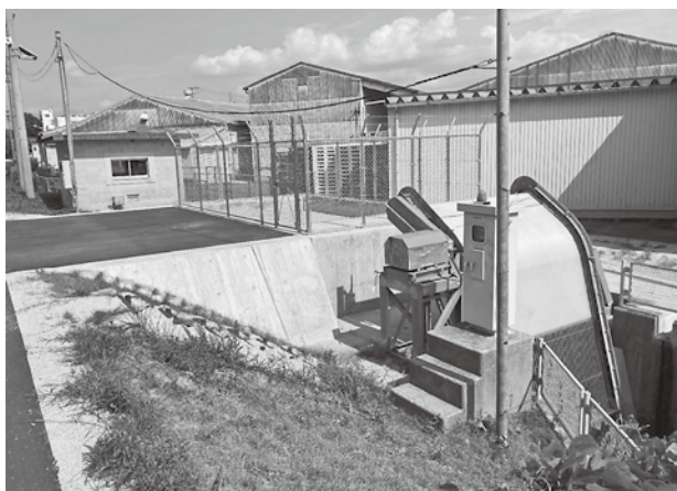
八代川排水機場への導水路の改修。効果が期待される
