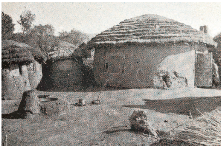
穀物倉庫をもつ固定住居の「ゲル」 (現中国内モンゴル自治区ヒンガン盟ジャライド旗、1939年)
