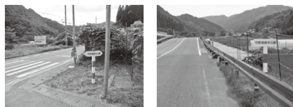
▲江野地区と竹野町林地区の中心線表示杭
