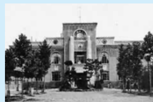
▲建設当初の旧町役場
