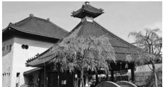
建替えを進めている「城崎温泉交流センター」
