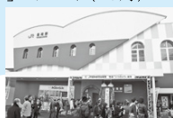
▲完成した駅舎
