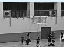
▲大型スポットエアコンを整備した豊岡南中学校
