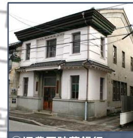
⑧旧豊岡貯蓄銀行 和洋折衷の装飾的な特徴を持ち、軒裏は漆喰塗りや銅板張り、隣家との間には袖うだつを設けた木造防火建築。
