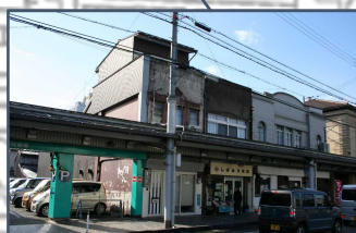
④旧5軒長屋 当初は5軒あったRC造2階建の3軒長屋。除却された2軒のRC造の柱や梁が今でも残る。
