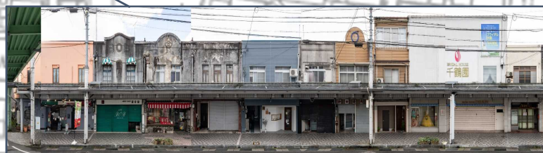
⑤大開通南側長屋 復興期に建築された最も大きな長屋で、大開通りに面する部分をRC造とすることで、都市の防火帯として機能している。また、一部に残るモルタル塗りの外観は建設当初の面影と時代の経過を感じさせる景観となっている。
