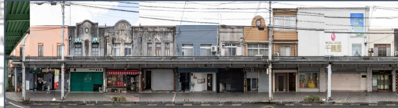
⑤大開通南側長屋 復興期に建築された最も大きな長屋で、大開通に面する部分をRC造とすることで、都市の防火帯として機能している。また、一部に残るモルタル塗りの外観は建設当初の面影と時代の経過を感じさせる景観となっている。
