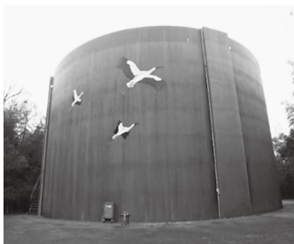
▲妙楽寺配水池
