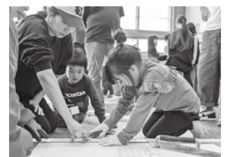
▲断熱ワークショップで断熱ボードの取付を行う
