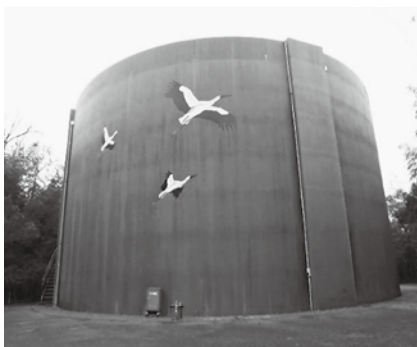
▲妙楽寺配水池
