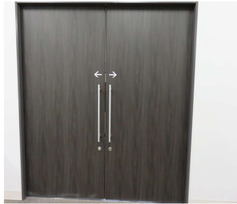
交流室3-1室内側正面
