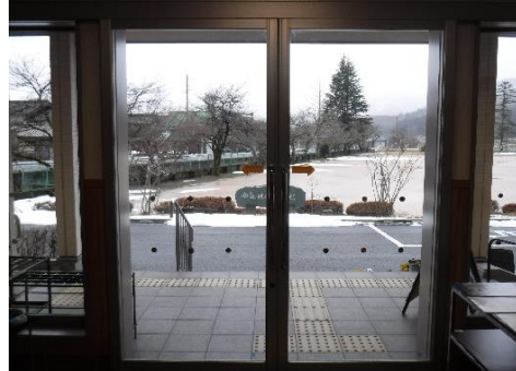
②センター玄関内側
