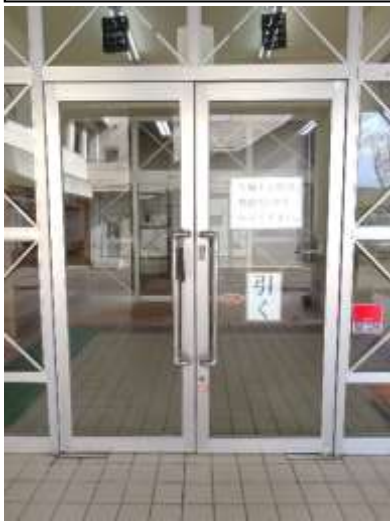
③ 室外側正面
