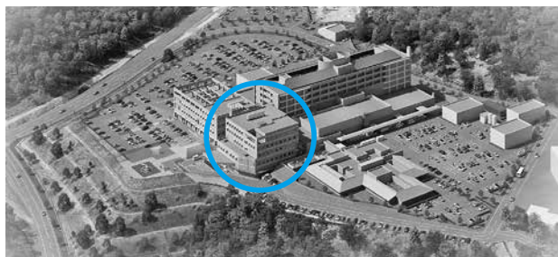
救命救急センターの拡張整備等が計画されている豊岡病院
