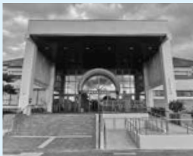
▲屋根や外壁が改修され、新しく生まれ変わった総合体育館
