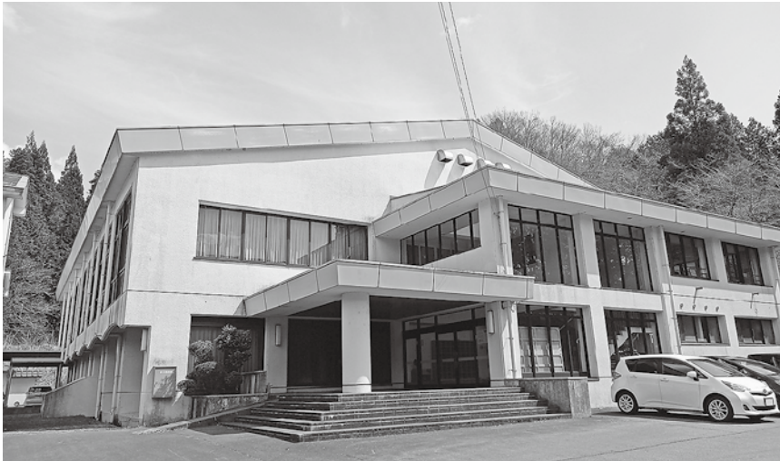
民間事業者により有効活用される旧竹野南小学校（体育館）
