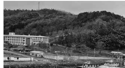
施設の整備が予定される旧県立豊岡南高等学校跡地
