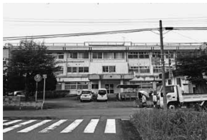
新館が解体される日高医療センター
