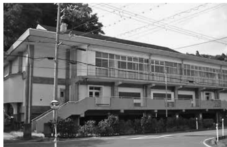
コミュニティ活動拠点として大切な施設(体育館)
