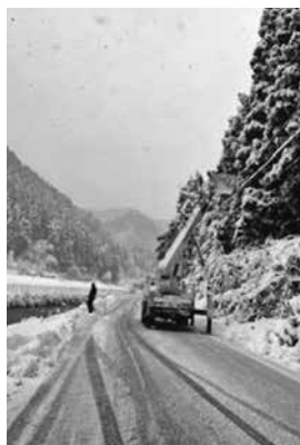
雪害倒木による停電復旧作業の様子
