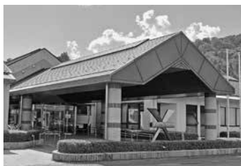
地盤沈下が懸念される出石健康福祉センター
