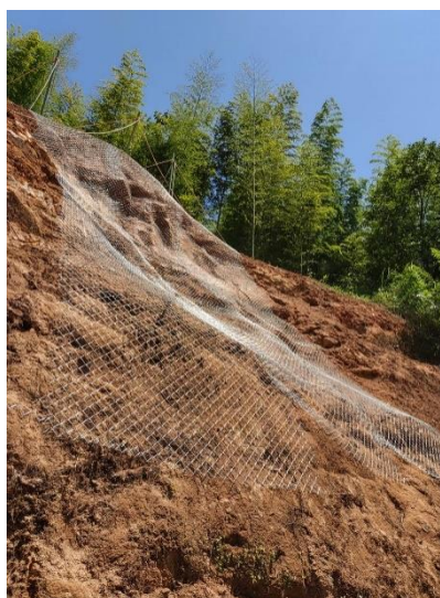
《オーバーハング部分除去》
