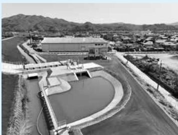
▲完成した排水機場
