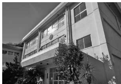
適正管理と利活用が望まれる旧港西小学校
