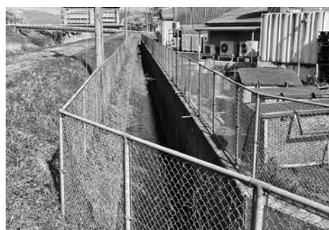
八代排水機場への内水導水路
