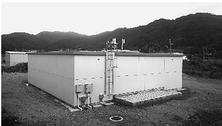
発電機は、災害や事故など、不測の停電時でも施設の運転、配水池への送水に備えるため、水道事業に欠かせない設備です。
