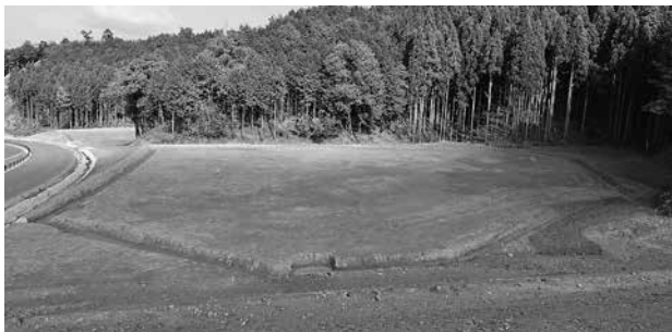
24年度分譲開始に向けて整備を進めている産業用地
