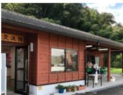
市内の木造公共建築物
