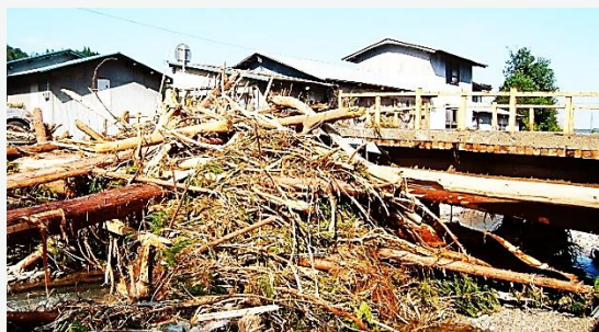
資料4 2004年10月20日に発生した台風23号による被害の様子
