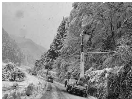
昨年12月18日、積雪倒木による停電の復旧作業現場
