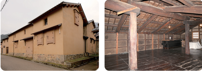
写真左：出石酒造土蔵(第二酒蔵庫) 写真右：出石酒造土蔵(第一酒蔵庫)
