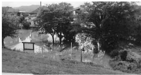
西芝樋門付近の浸水被害（平成30年7月豪雨）
