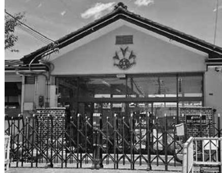
2023年度めぐみ幼稚園との統合予定のひかり幼稚園舎
