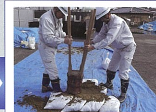
⑥ 土をかけ、足かタコでならして土のうの隙間を埋めます。
