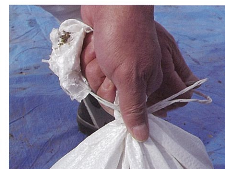
② 右手に持った紐を左手親指の下に通し、甲を通過して左手を二周させます。
