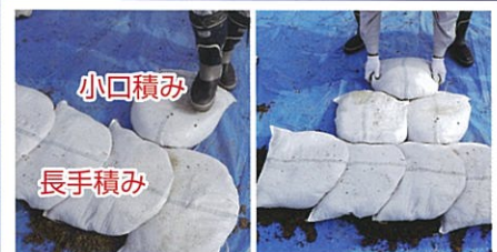
⑤ 前列の隙間を埋めるように、後ろに土のうを縦に並べていきます。前列の並べ方を長手積み、後列の並べ方を小口積みといいます。
