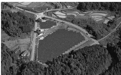
市内3カ所にある市の大規模太陽光発電施設。約800軒分の電力を発電している
