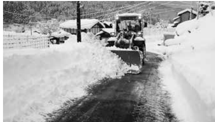
受託業者等の協力により除雪が行われています
