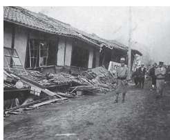
▲豊岡駅前の被害
