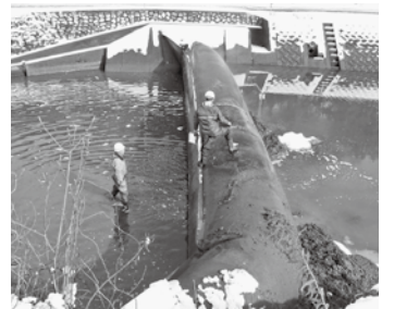
井堰の点検管理
