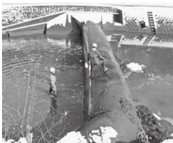
井堰の点検管理
