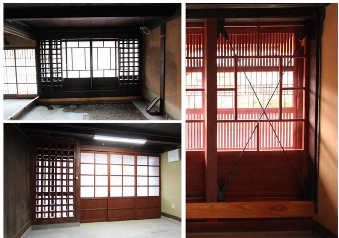
図1 保存地区内で、修理時に行う格子壁等による補強
