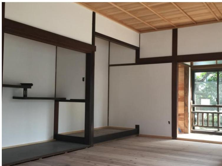
写真1 乾式土壁パネルの適用例
