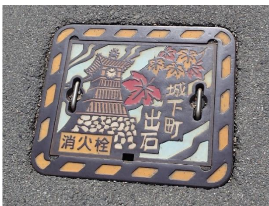
写真1. 地下式消火栓
