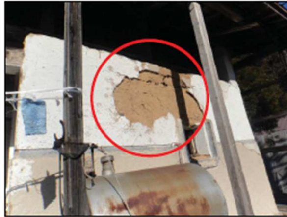
【モルタル塗り仕上等】 仕上材が脱落しており、下地材にひび割れが生じている。
