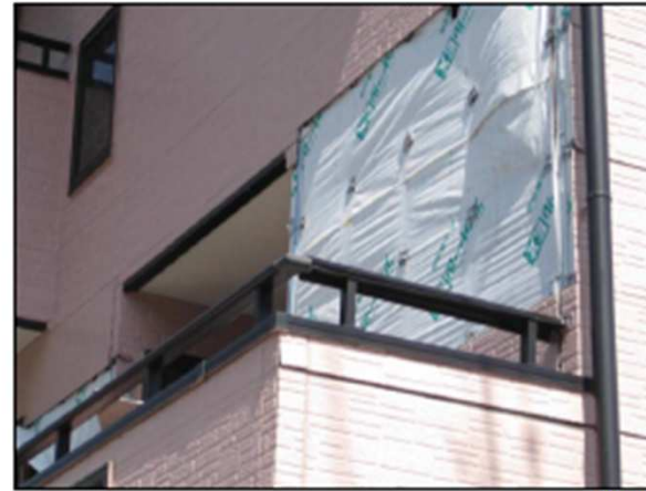
【ボード】 釘の浮き上がり、ボードの脱落が見られる。
