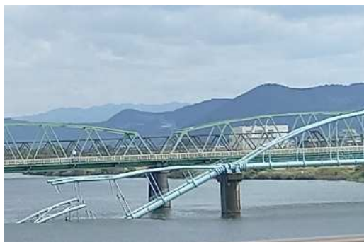
和歌山市の水管橋崩落事故 (2021年 給水応援派遣時に撮影)
