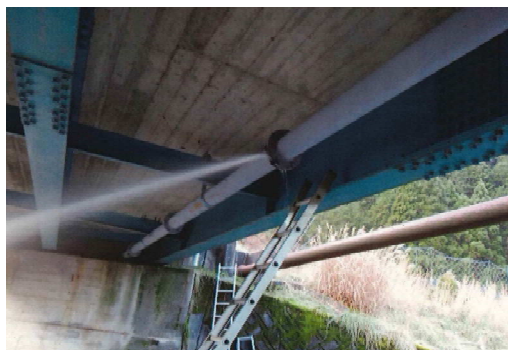
橋下部配水管からの漏水 (2018年 豊岡市内)
